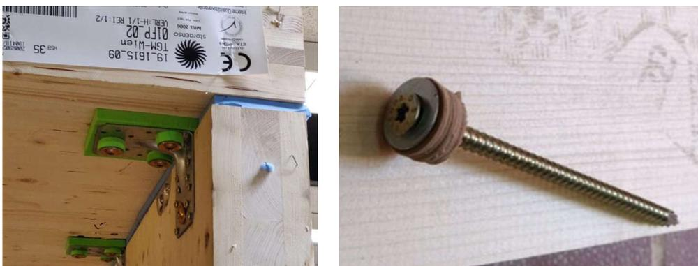
Abbildung 15: Beispiele von Entkopplungsmaßnahmen im Verbindungsmittel beim Winkel (links) und der Tellerkopfschraube (rechts)
