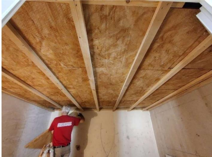
Abbildung 29: Montage der freitragenden abgehängten Unterdecke im Empfangsraum
