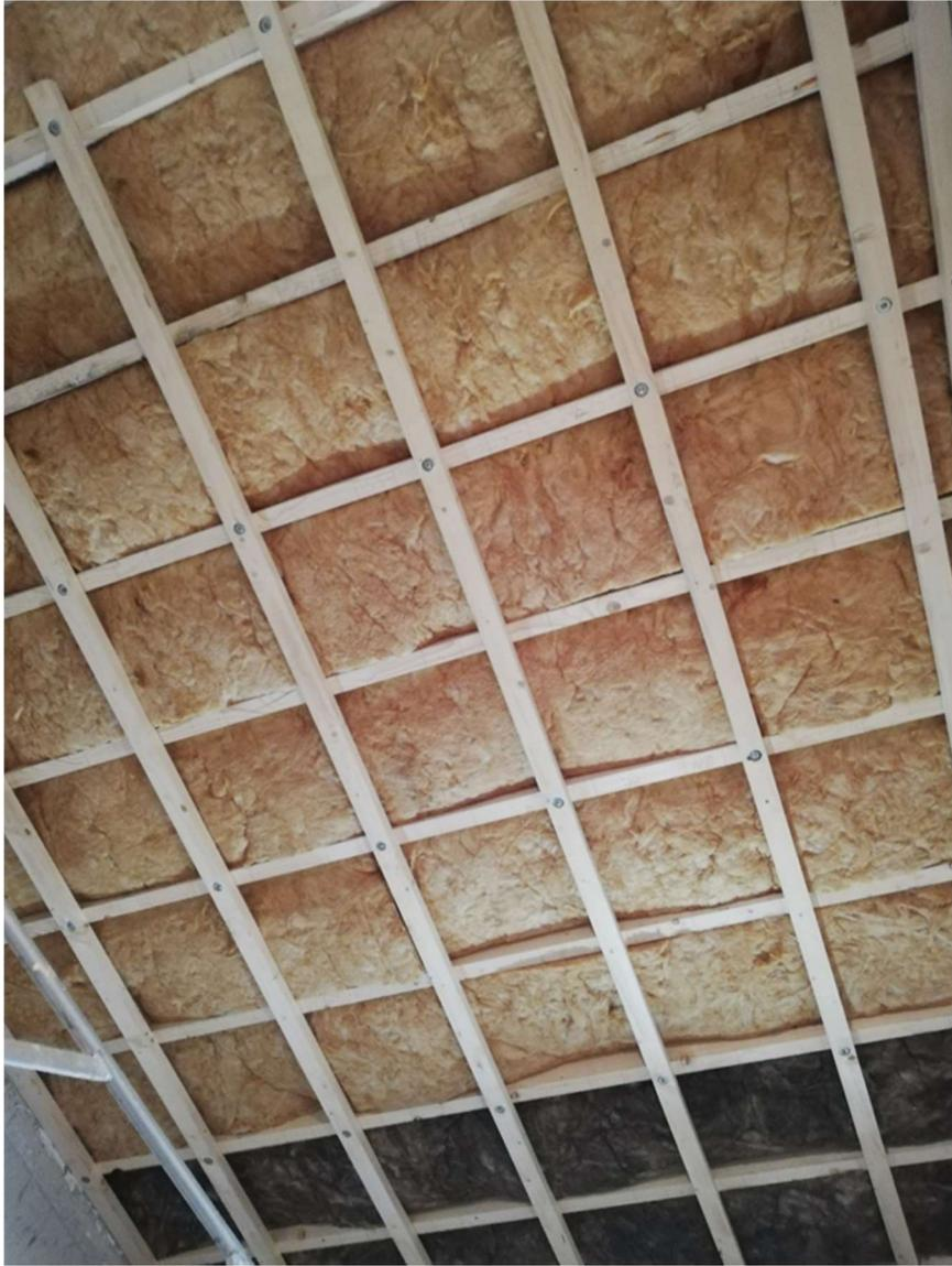
*Abbildung 63: Ansicht des abgehängten Lattensystems vor der Montage der Beplankung*
