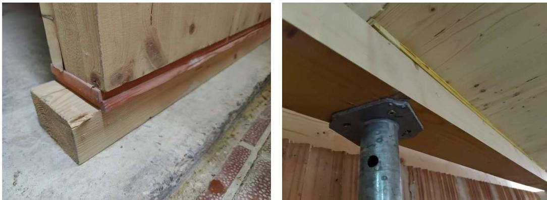
Abbildung 4: Wandauflager (links) Deckenauflager (rechts)
